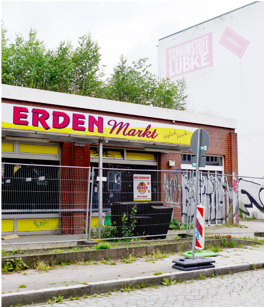
Abb. 58: Ladengeschäft vor dem Abriss an der Virchowstraße. Im Hintergrund eine ehemalige Produktionsstätte für Schaumstoffe (eigene Darstellung 2020)
