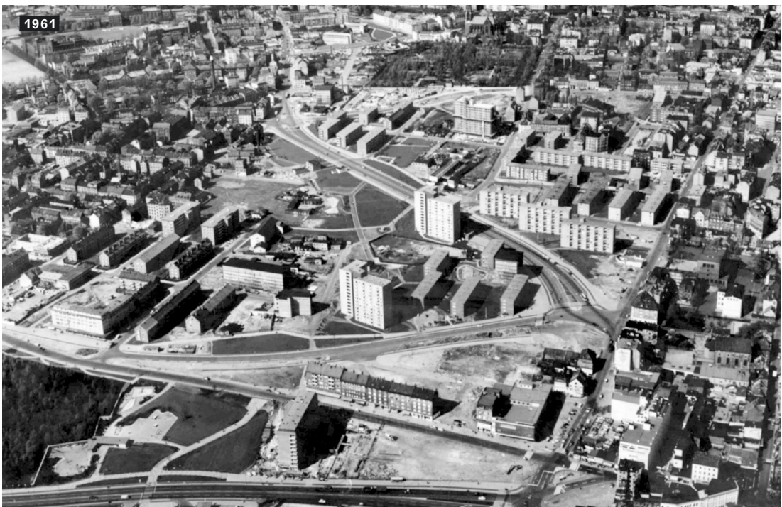
Abb. 32: Planung Neu-Altona mit Grünzug, Baufortschritt 1961 (FHH 2007)
