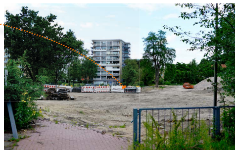
Baustelle des neuen Schulcampus: Die Arbeiten betreffen die Notbetreuung & den Jugendclub, die nun geschlossen sind. Hinten: Hochhaus im Bereich K VIRCHOWSTR. (eigene Darstellung 2020)
