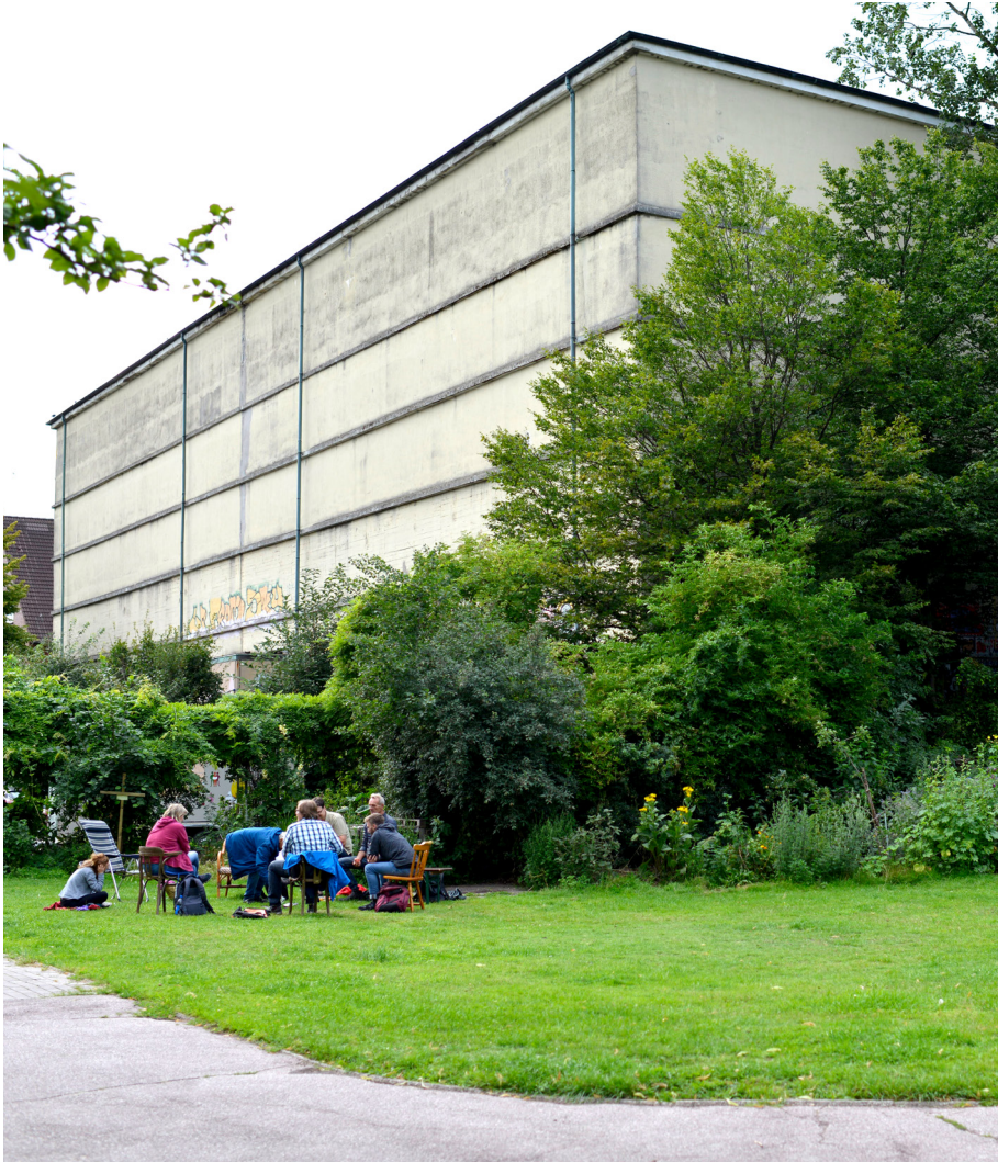
Abb. 42: Hochbunker an der Schomburgstraße 6-8 mit Freiwilligen des Vereins KulturEnergieBunkerAltonaProjekt KEBAP (eigene Darstellung 2020)
