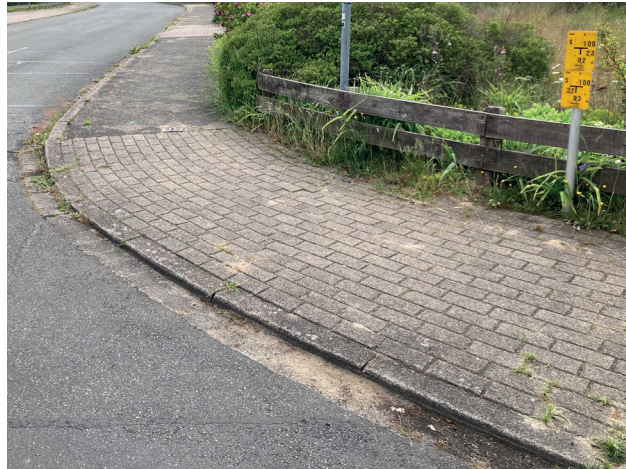
Abb. 35: Nicht ausreichend abgesenkte Bordsteinkante
