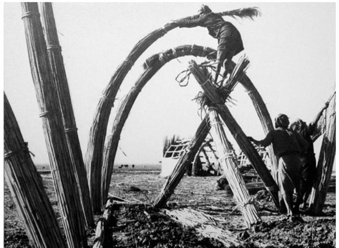
*Abb. 21: Die gegenüber stehenden Schilfpfosten werden von einem Mann, der auf einem Dreibein steht, mit einander verbunden*
