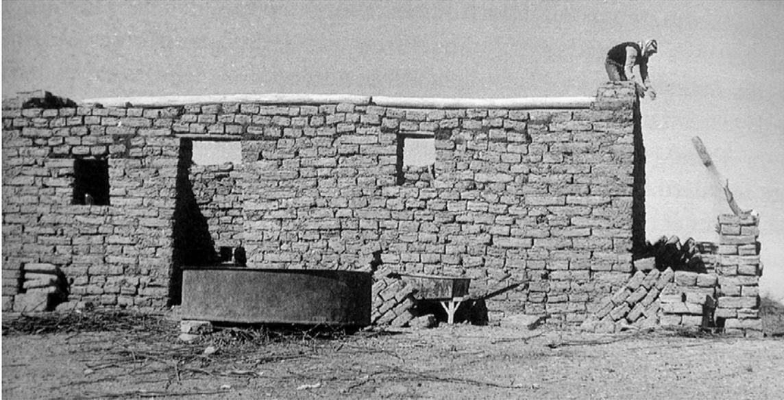
*Abb. 31: Der mu'allim beim Bau eines Lehmhauses. Ein Helfer wirft ihm Lehmziegel hoch*
