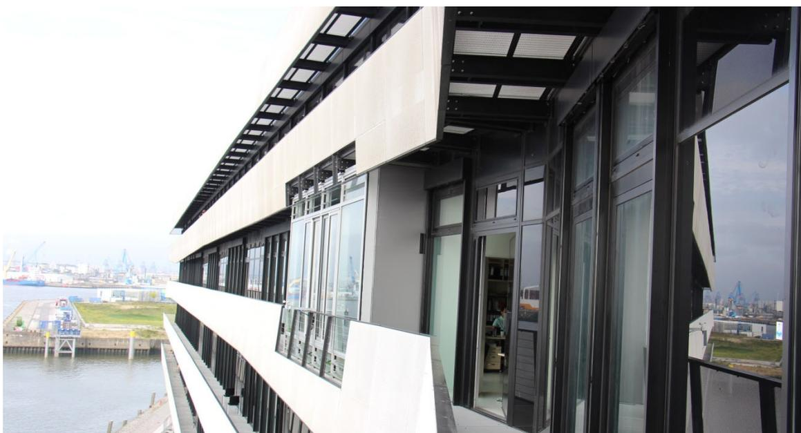
Abbildung 2: Außenansicht der Bypass-Doppelfassade
