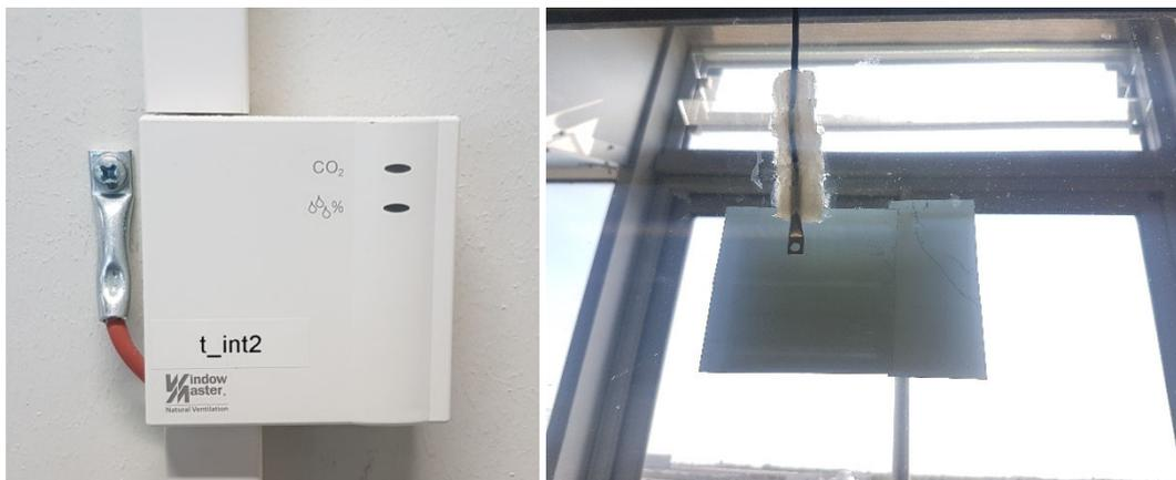
**Abbildung 9: links: Kombinationssensor WET 112 mit einem Oberflächentemperaturfühler Pt1000, rechts: mit reflektierender Folie geschützter Glas-Oberflächentempersensor**
