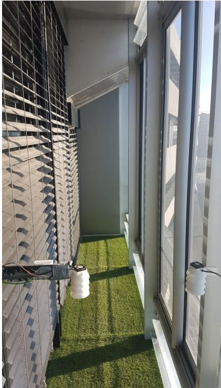
**Abbildung 56: Blick in den Fassadenzwischenraum mit heruntergefahrenem Sonnenschutz**
