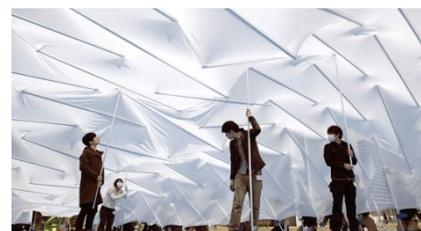
4-7 Aufrichten des Pavillons MOOM durch innenseitiges Anheben der Pavillonfläche und gleichzeitigem Verschieben der Fußpunkte.
