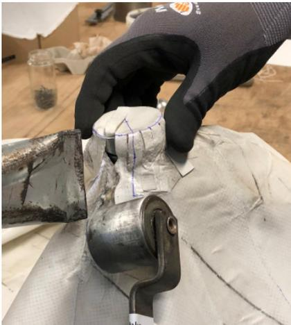
6-37 Handwerkliche Fertigung des Anschlussbereichs mit dem Warmgas-schweißverfahren
