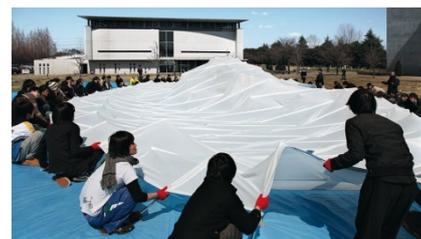
4-6 Einführen der Druckelemente in die aufgenähten Futterale beim Pavillon MOOM
