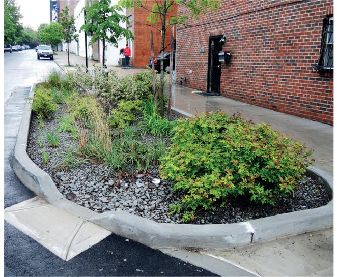
Pflanzgruben Typ 3 – Kombination aus Regenwasserversickerungsmulden mit Randsteinöffnungen (Pfeile) und Baumstandorten in München (Foto: Wolfgang Dickhaut 2017, links) und Typ 1 in Kombination mit Typ 3 – Tiefbeete mit Regenwasserabfluss in New York City (Foto: Elke Kruse 2015, rechts)
