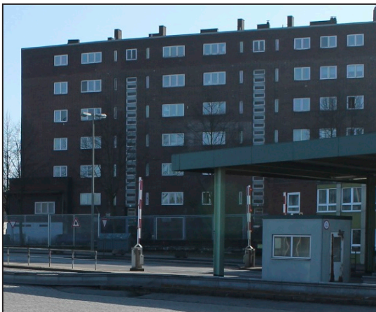
Abb. 16: Wohnungen an der Tunnelstraße I
