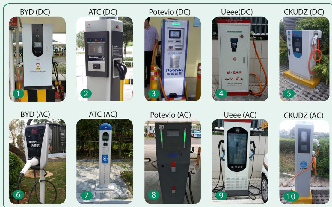
Abb. 3.18: Auswahl von unterschiedlichen Anbietern und Varianten von AC- und DC-Ladesäulen in Shenzhen
