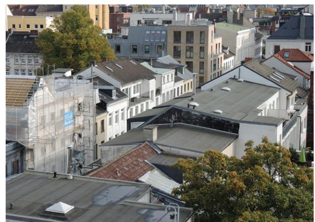
Abb. 7.1: Blick über typische Dächer in Hamburg, abgedichtet mit Bitumen und mit Dachziegeln als Dachdeckung.
