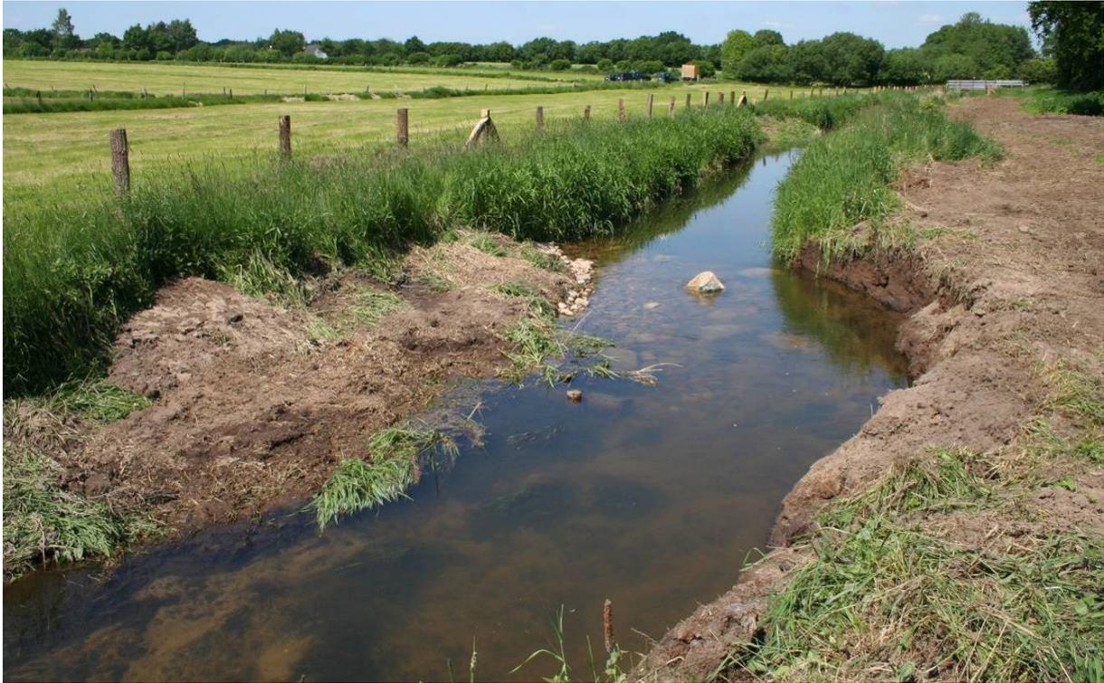
Abbildung 69 - Fotoaufnahme der Steinau/Büchen mit der Verschwenkung und den den Strukturelementen im Feld „Störsteinberme 2007“, Bauabnahmetermin nach Fertigstellung, Foto: Giese 23.05.2007
