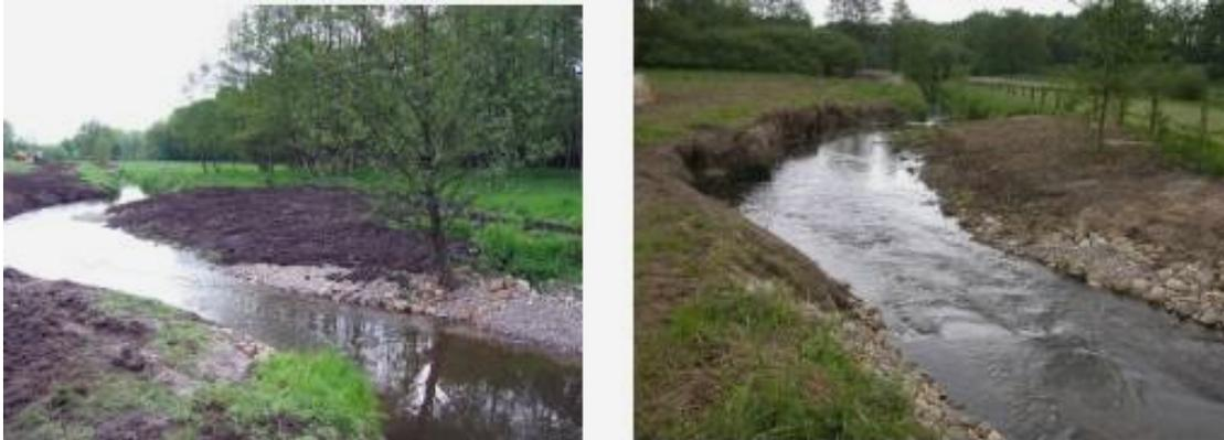
Abbildung 77 - Verschwenkung im Bauzustand (links), Abbrüche am Steilufer (rechtes Bild) Fotos Greuner-Pönicke
