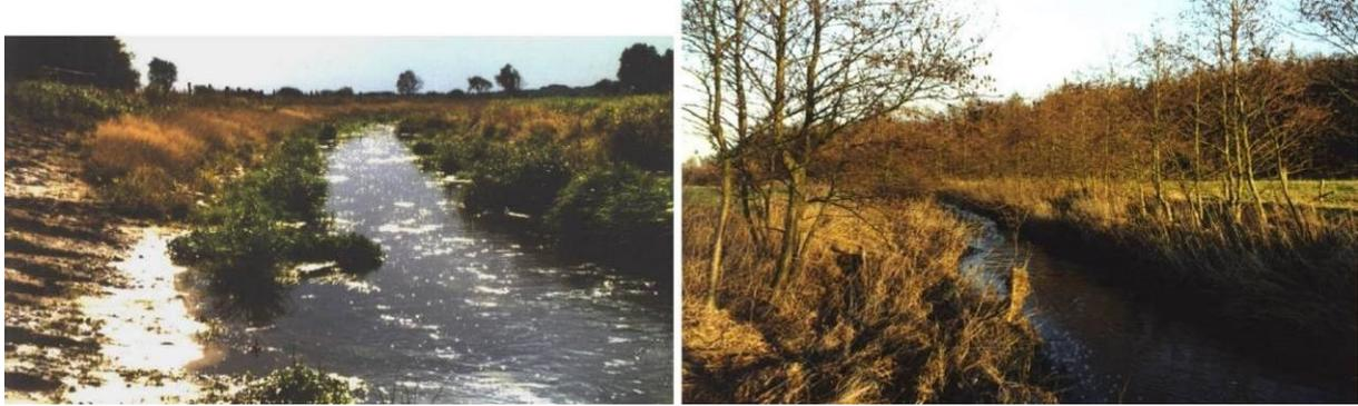
Abbildung 27 - Umgestaltung der Buckener Au nach dem Prinzip der Uferabflachungen in den 1980er Jahren sowie nachfolgende Entwicklung, Fotos Greuner-Pönicke
