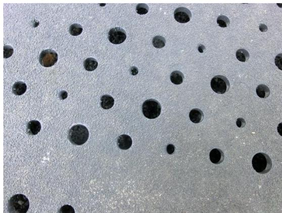
Abb. 18: Versickerungslöcher in den Baumrosten
