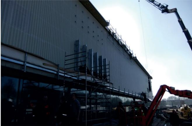
Abbildung 83: Montage der Elementschienen
