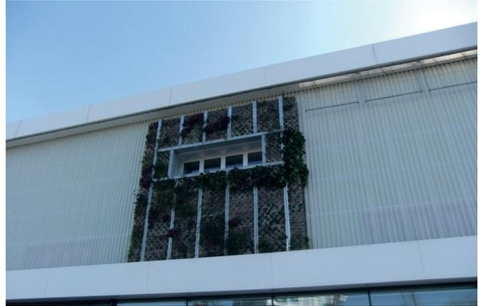
Abbildung 85: Pflanzelement kurz nach der Montage
