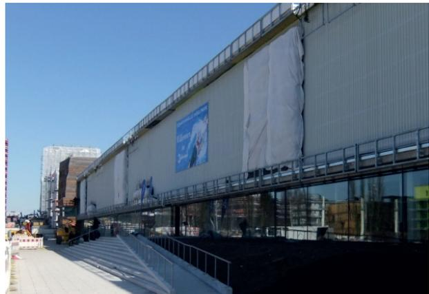
Abbildung 34: Pflanzelemente kurz nach der Montage im Frühjahr
