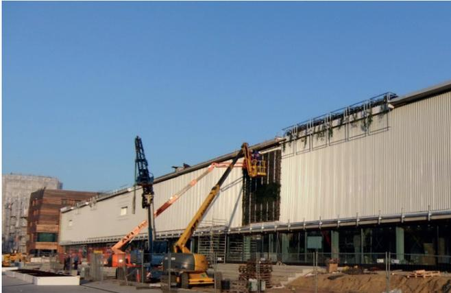
Abbildung 84: Montage Pflanzelemente
