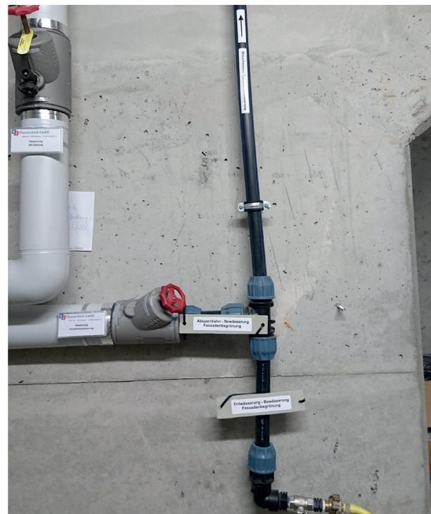
Abbildung 25: Mögliche Zuleitung für Dünger
