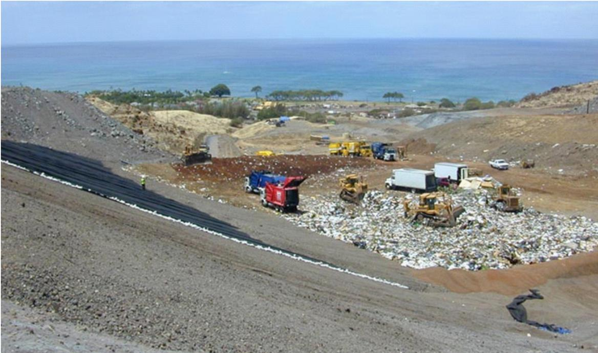
Abb. 3: Aufbau einer Deponie für Hausmüll
