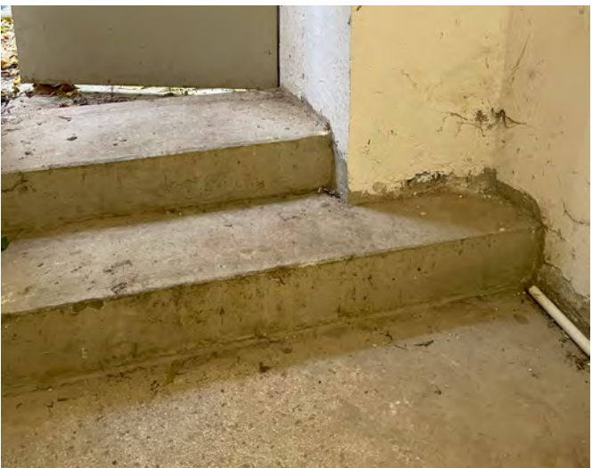
Abb. 2.5: Kellerraum Außenwand Rückfassade
