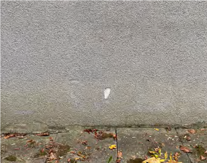
Abb. 14.5: Rückfassade Putzschäden
