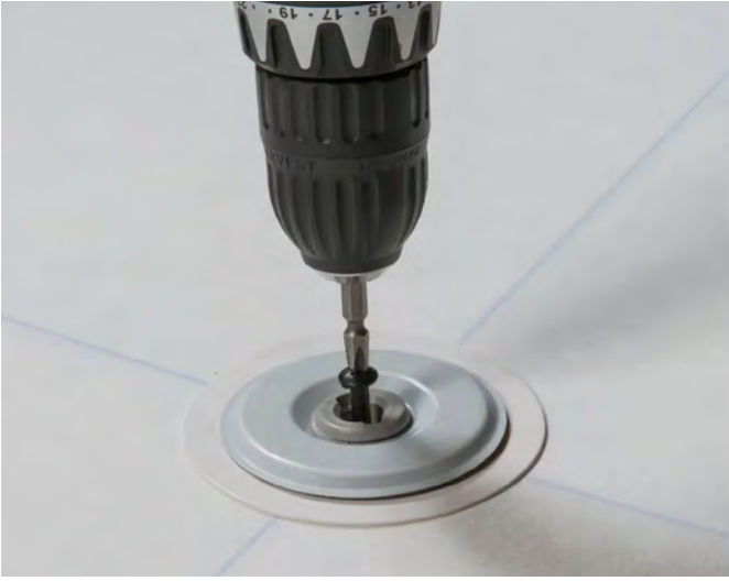
Abb. 17.14: Aufschrauben der Halteteller für die EPDM-Plane
