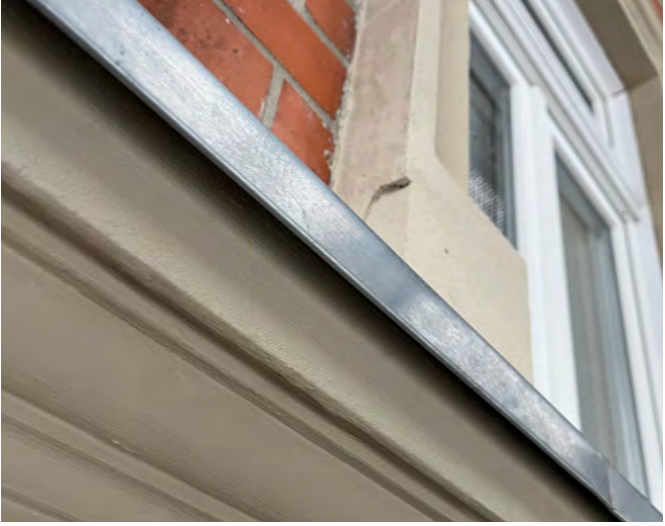
Abb. 8.12 Blech verklebt mit Enkolit; bietet einen Witterungsschutz
