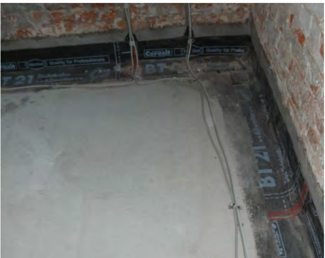
Abb. 3.18: Erneuerung der Bodenplatte - Abdichtungsfolie oberhalb neuer Sohle
