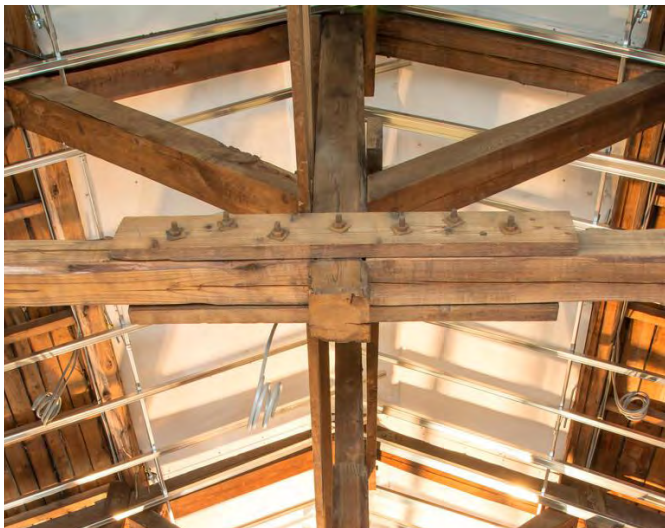
Abb. 17.10: seitliches Verstärken der Dachpfetten
