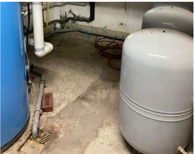
Abb. 3.5: Sanierung des Terrazzobodens durch Beton, mittig der Bodenplatte
