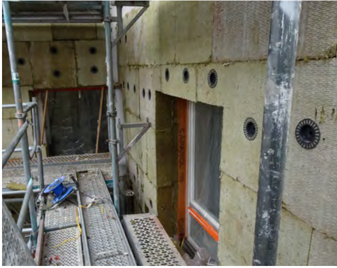
Abb. 14.8: Fassade mit WDVS (gedübelt)
