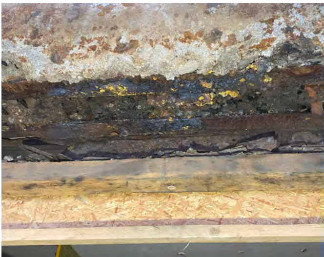
Abb. 6.39: Korrosionsschäden
