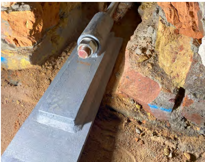
Abb. 6.31: Zugbandhülse und Gewindestange
