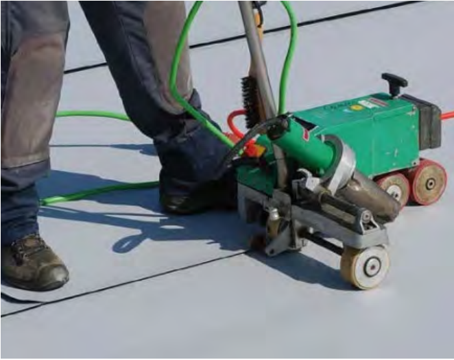
Abb. 10.17: Heißluftverschweißung
