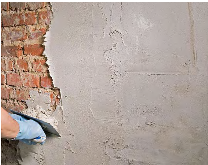
Abb. 7.15 Auftragen des Sanierputzes
