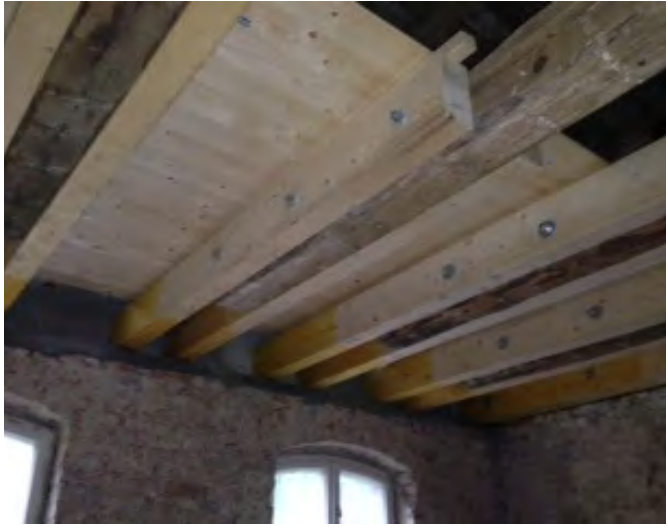
Abb. 11.8: durch Anlaschungen sanierte Holzbalkendecke
