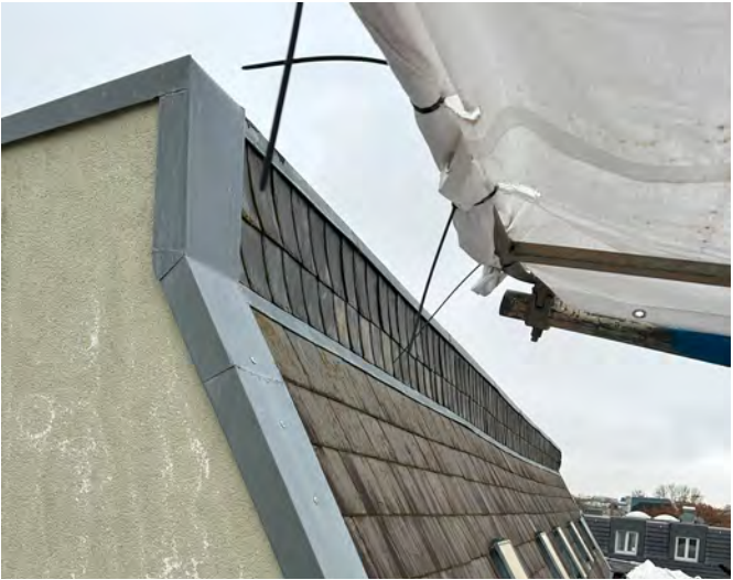
Abb. 17.3: Übergang zu geneigtem Dach
