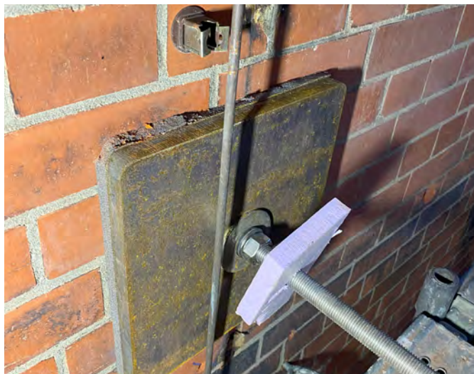
Abb. 6.29: Ankerplatte
