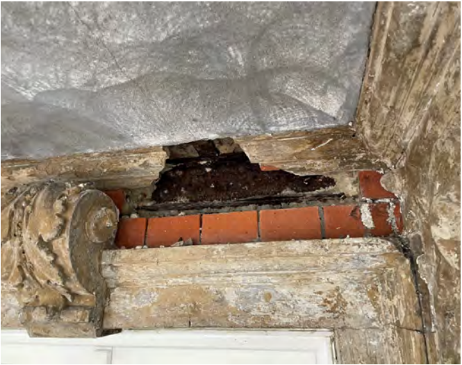
Abb. 9.3: Unterlagsträger, Position aufliegender IPN-Träger
