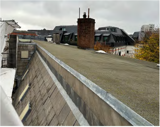
Abb. 17.2: Blick auf Flachdach und Übergang zu geneigtem Dach
