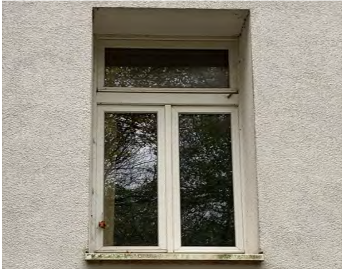
Abb. 15.8: Fenster nach Sanierungsmaßnahmen
