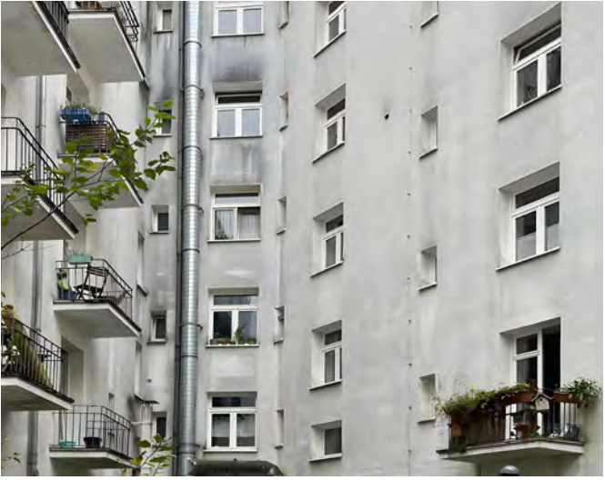
Abb. 13.2: Rückfassade Stelling Weg 36
