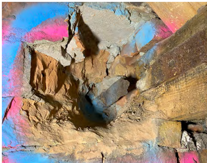
Abb. 6.37: Korrosionsschäden
