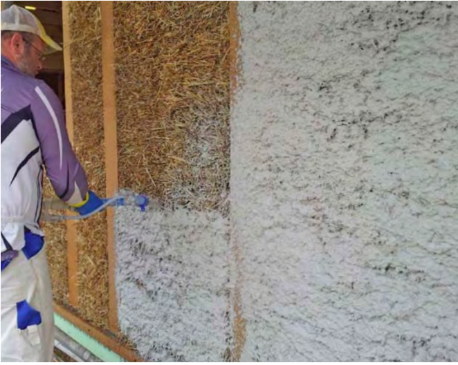
Abb. 14.14: Strohdammmung in Holzrahmen-Konstruktion mit Kalkputz
