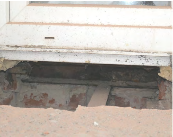
Abb. 9.4: Oberlagsträger unter der Fensterschwelle
