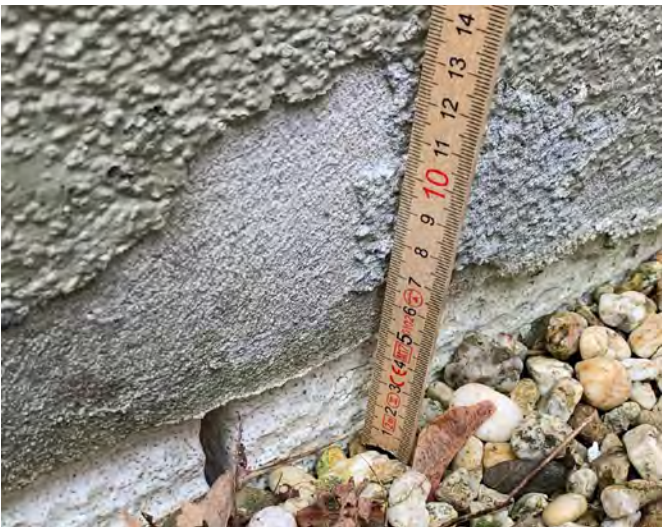
Abb. 14.6: Putzschäden Detail
