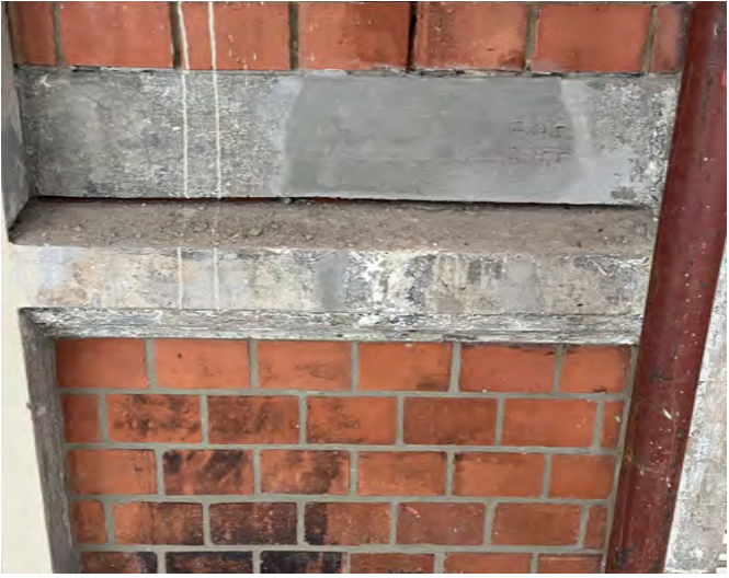
Abb. 8.8 Gesimse und Stuck werden gestrahlt oder gebeizt
