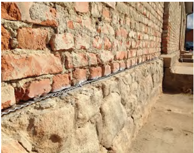
Abb. 7.23: Horizontalsperre
