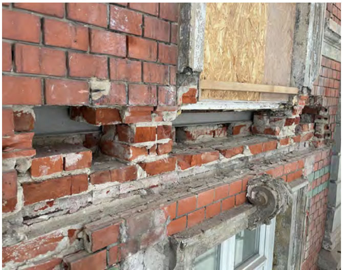
Abb. 9.10: Oberlagsträger mit Korrosionsschutz
