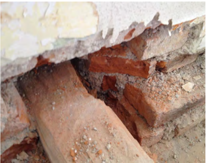
Abb. 11.4: Balkenkopfanschluss an Mauerwerk
