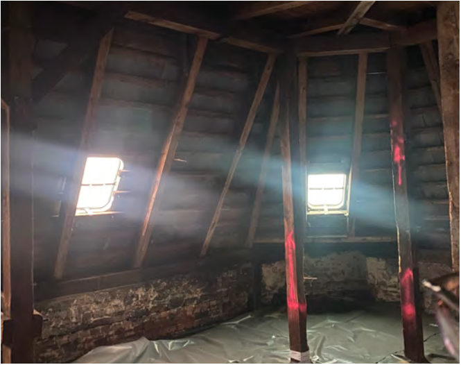
Abb. 16.5: Sparrenlage Dachstuhl
