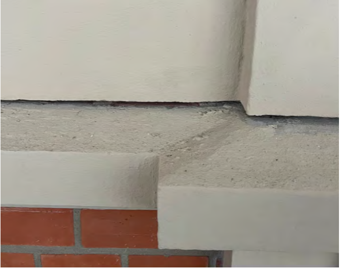
Abb. 8.10 Gesimse erhalten einen Schlitz für die neue Verblechung
