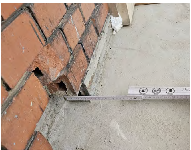
Abb. 9.12: neuer Gefälleestrich, Schnittstelle Vormauerwerk
