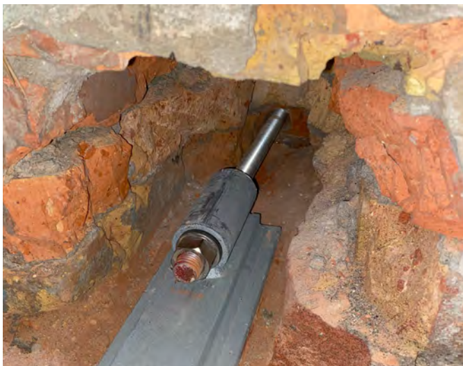
Abb. 6.30: Zugbandhülse und Gewindestange
