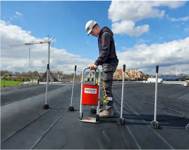
Abb. 17.15: Befestigung der EPDM-Plane mittels Induktionssystem
