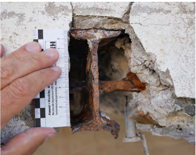
Abb. 9.5: IPN-Träger, Zugband (Rundstahl)
