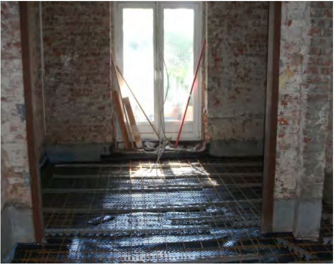
Abb. 3.17: Vorbereitung der neuen Sohle - Trennschicht mit Mattenbewehrung
