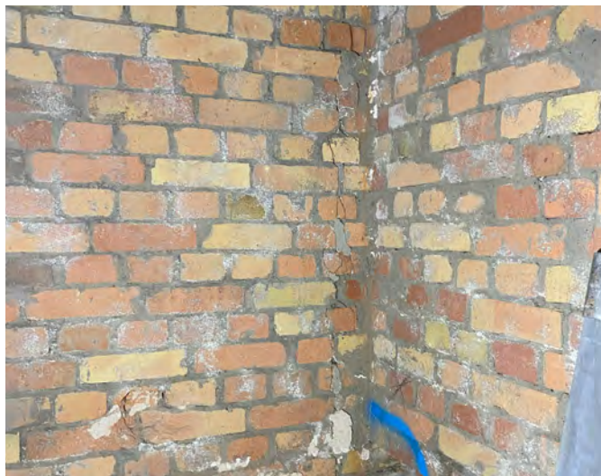
Abb. 6.17: Vertikaler Riss
