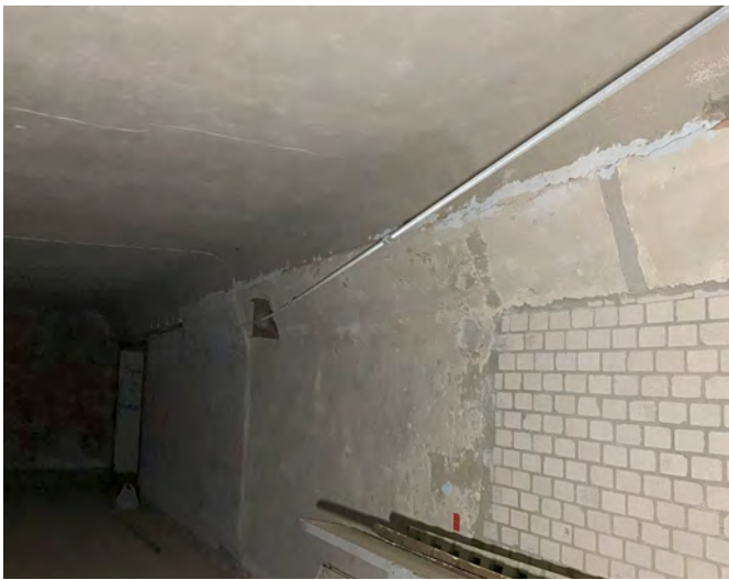
Abb. 6.27: Zugband zur temporären Absicherung
