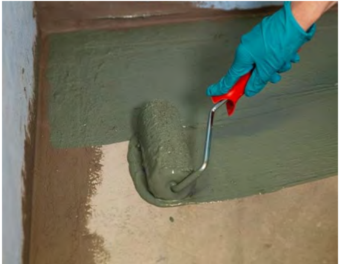
Abb. 3.10: Ausführung der Dichtungsschlämme in der Praxis
