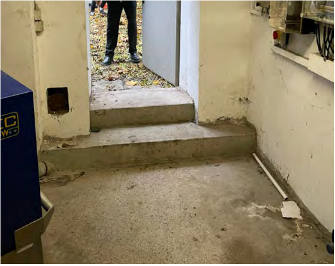
Abb. 3.2: Kellerraum als „Hamburger Souterrain“, mit Beton Stufen
