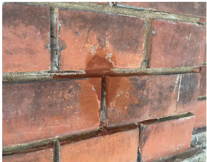
Abb. 5.12: Ziegelausbesserung mit Reparaturmörtel
