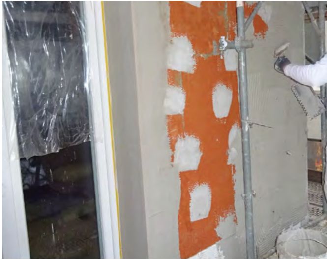
Abb. 14.9: Armierungsschicht
