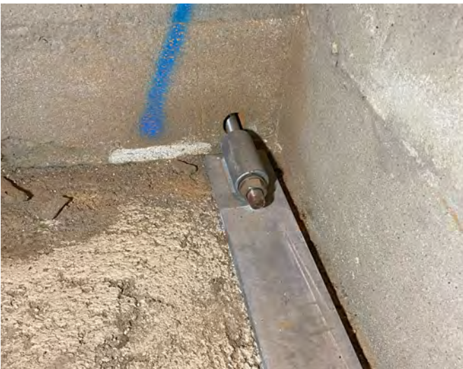
Abb. 6.36: Zugbandhülse
