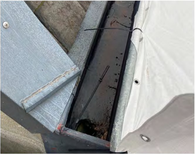
Abb. 16.3: Regenrinne auf Dachgesims
