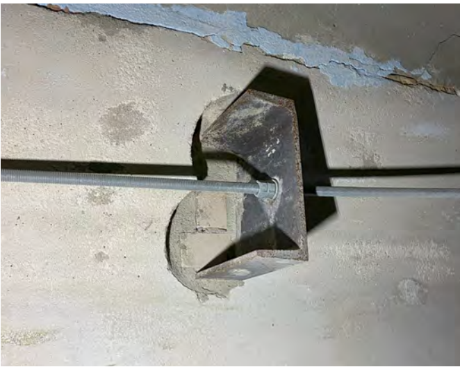
Abb. 6.28: Träger und Zugband zur temporären Absicherung
