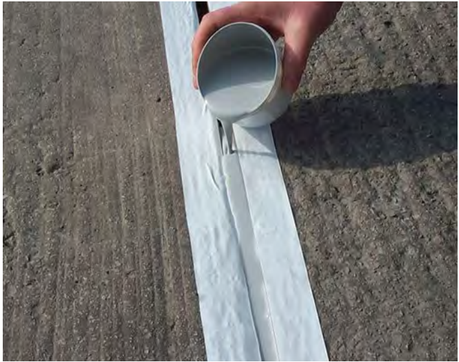
Abb. 7.21: Flexibler Füller für Dehnungs- und Bewegungsfugen
