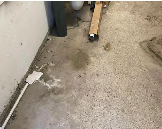
Abb. 3.4: Bereichsweise Sanierung des Terrazzobodens durch Beton - Wandseite
