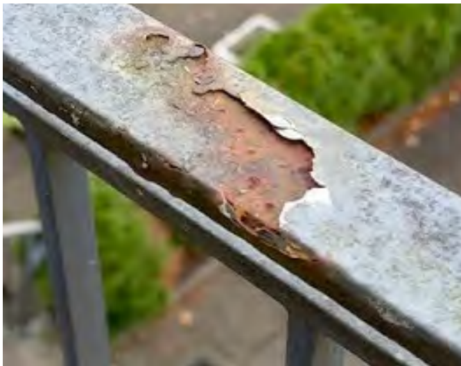
Abb. 10.4: Schadhafte Lackierung
