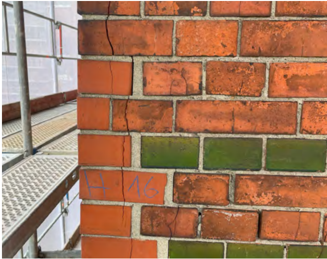
Abb. 6.3: Vertikale Risse
