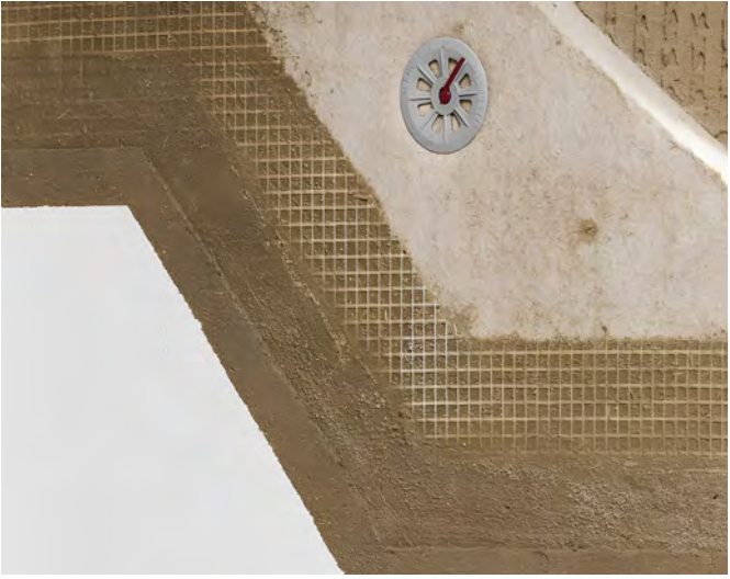
Abb. 13.14: Innendämmung mit Holzweichfaserplatten und Lehm
