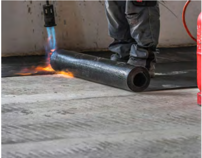
Abb. 3.9: Verlegung der Bitumenbahnen in der Praxis
