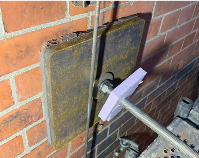
Abb. 6.9: Ankerplatte
