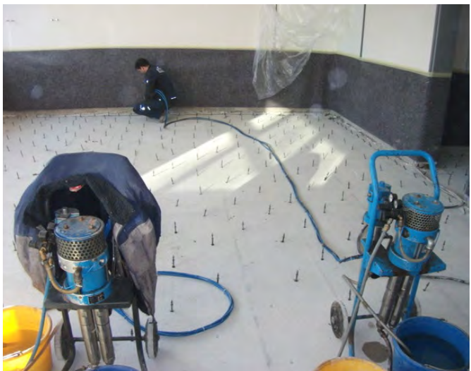
Abb. 3.12: Schleierinjektionsverfahren in der Praxis
