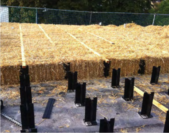
Abb. 14.15: Strohdammmung auf Dach
