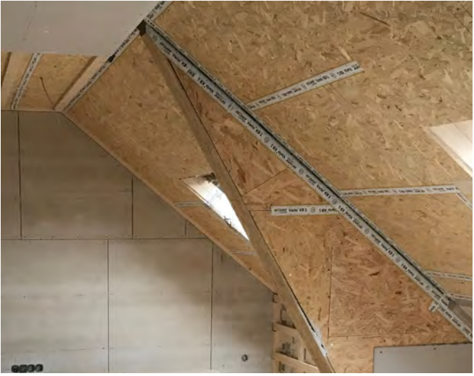
Abb. 16.14: Dampfsperre OSB Platten
