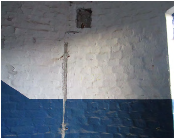
Abb. 6.6: Vertikaler Riss
