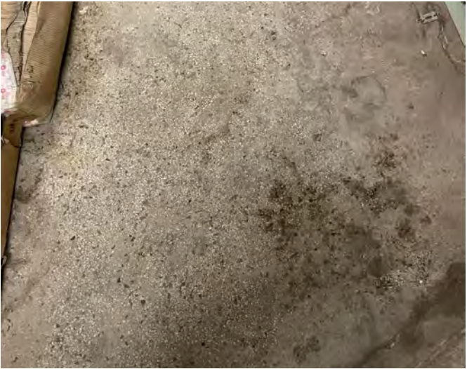
Abb. 3.3: Nutzschicht im Bestand: Terrazzo Boden
