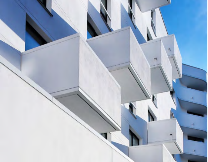
Abb. 9.17: Balkonverkleidung in Trockenbauweise
