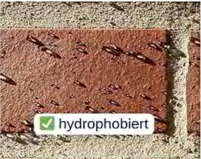
Abb. 5.18: Vormauerwerk mit Imprägnierung
