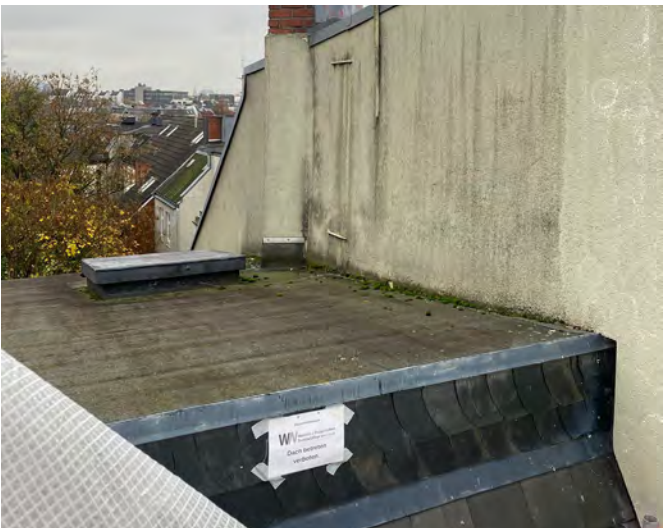
Abb. 17.4: Flachdach neben erhöhtem Gebäudeteil
