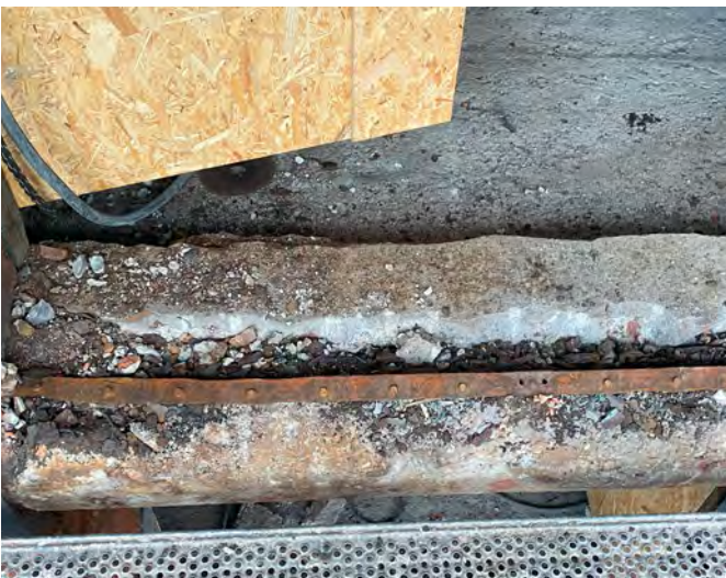
Abb. 6.40: Korrosionsschäden
