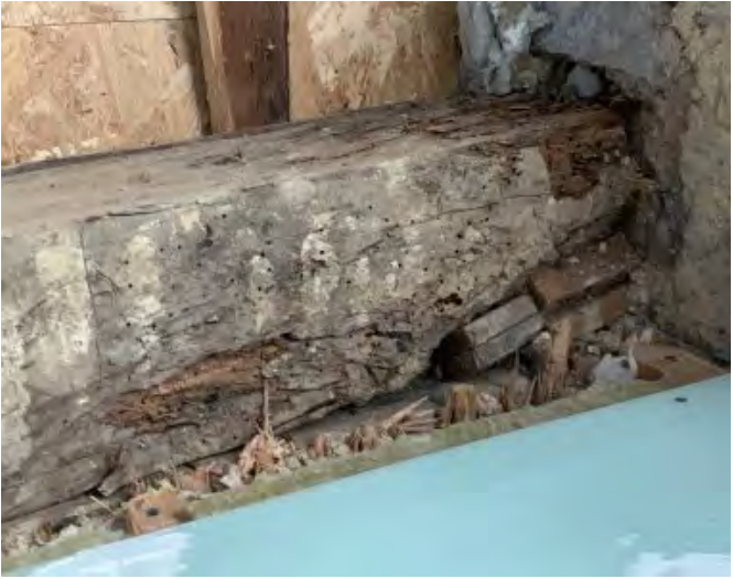
Abb. 11.5: Mangelhafter Balkenkopf
