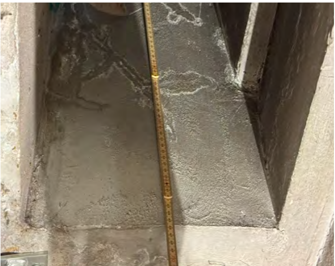
Abb. 4.4: Vermessung der Lichtschacht
