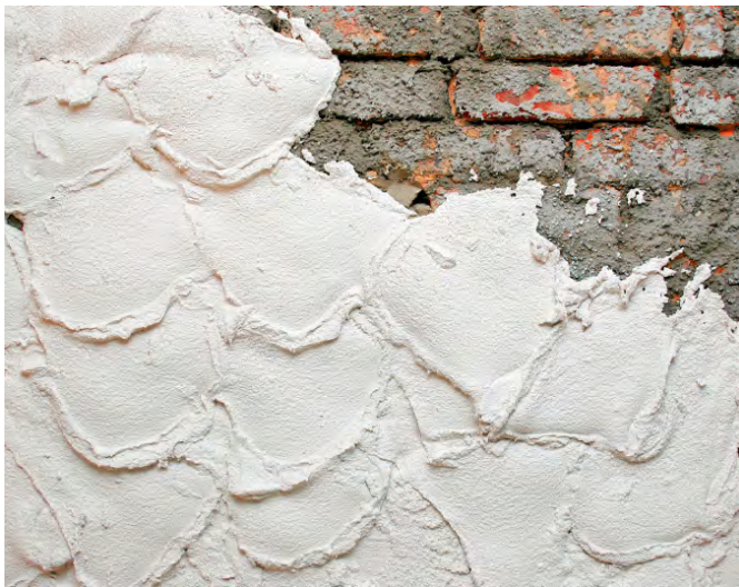
Abb. 7.14: Sanierputz von Hand angeworfen
