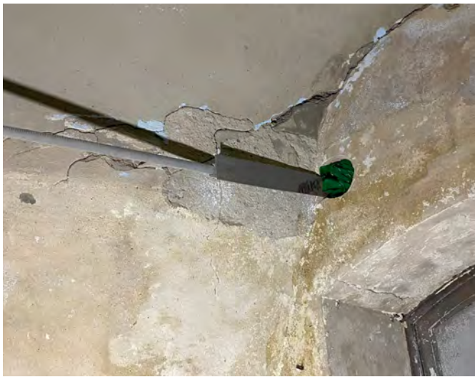
Abb. 6.26: Zugband zur temporären Absicherung
