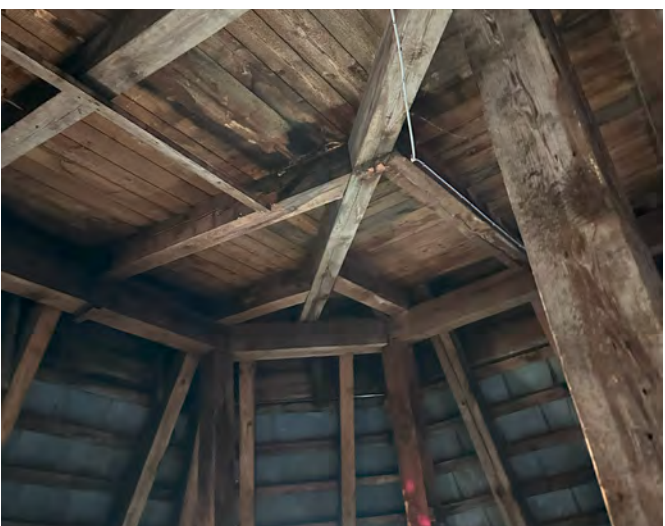
Abb. 17.6: Dachstuhl mit Übergang von Flachdach zu geneigtem Dach
