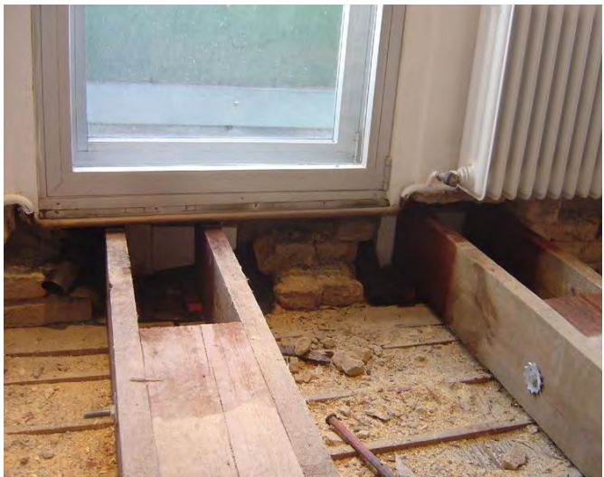
Abb. 11.10: Holzlaschen an gekürztem Balken
