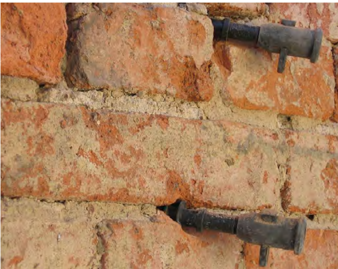
Abb. 6.12: Injektionspacker
