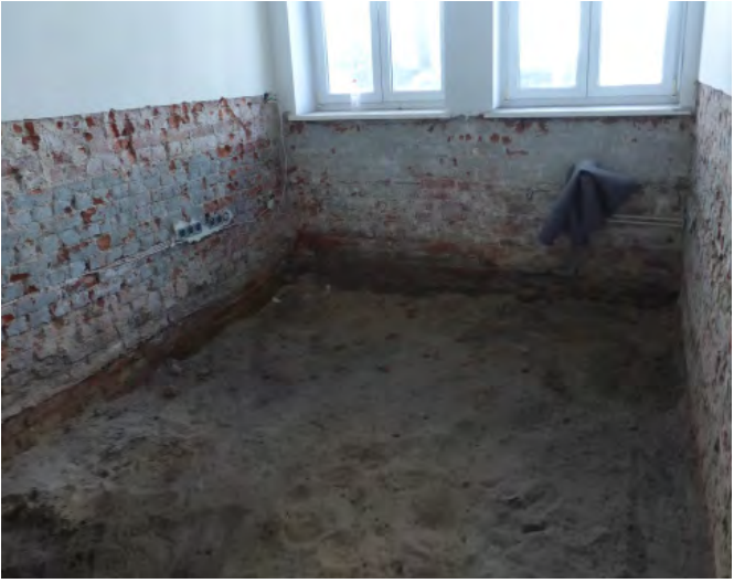
Abb. 3.16: Erneuerung der Bodenplatte - Erkennbare Sandschicht
