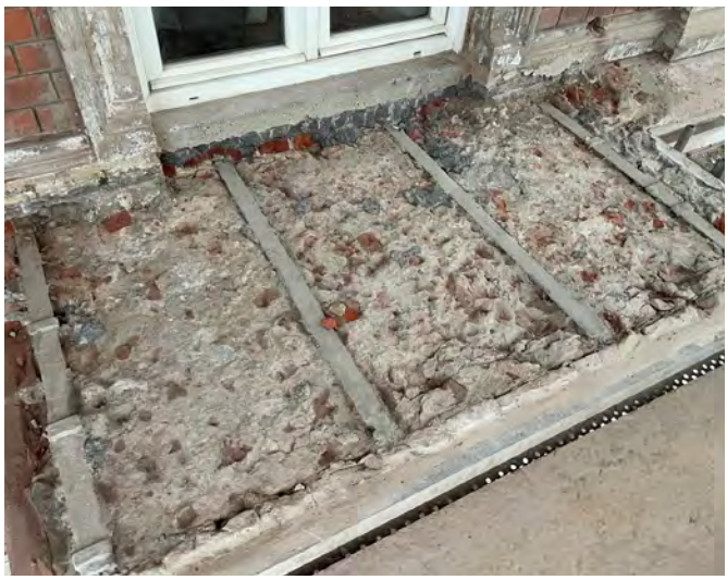
Abb. 9.8: Abstimmung Estrich und Ziegelsplittbeton
