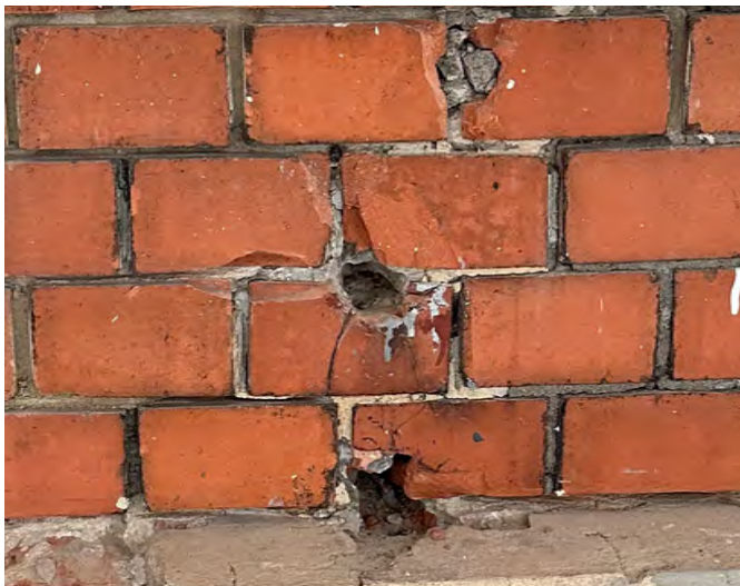
Abb. 5.6: Mauerwerksschäden
