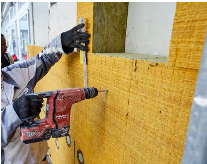
Abb. 14.11: Befestigung Mineralwollplatten auf Untergrund
