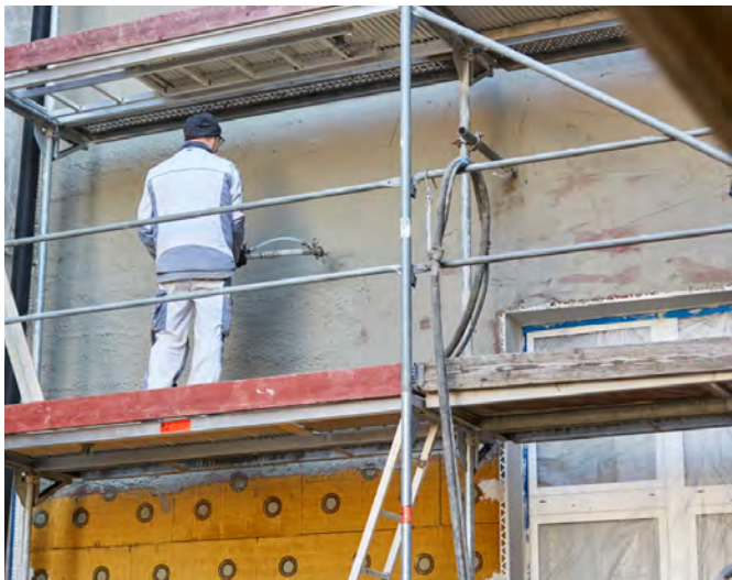
Abb. 14.12: Aufbringung Separationsschicht gefolgt von der Armierungsschicht
