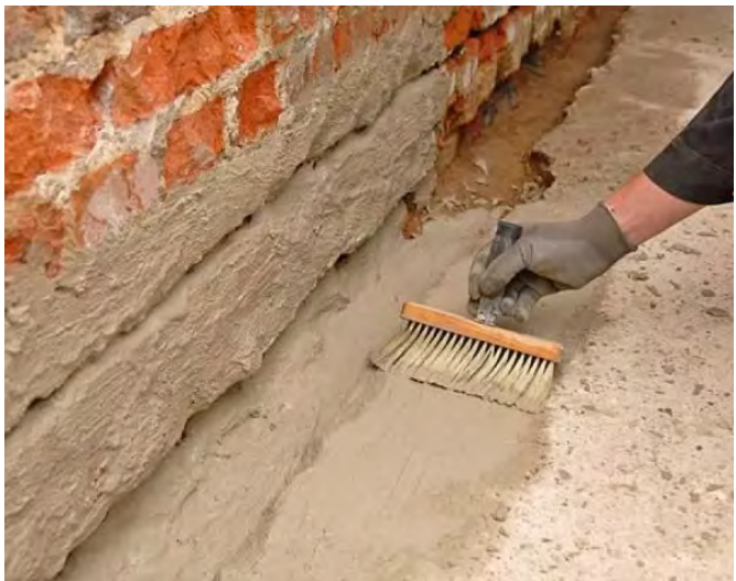
Abb. 3.11: Ausführung der Dichtungsschlämme in der Praxis
