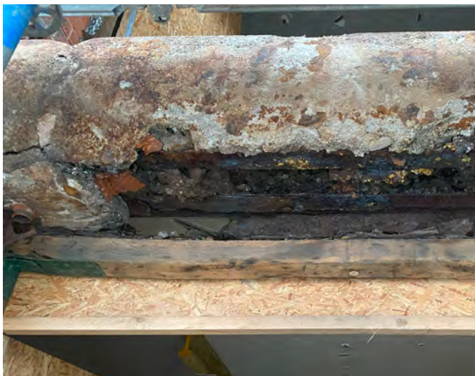
Abb. 6.38: Korrosionsschäden
