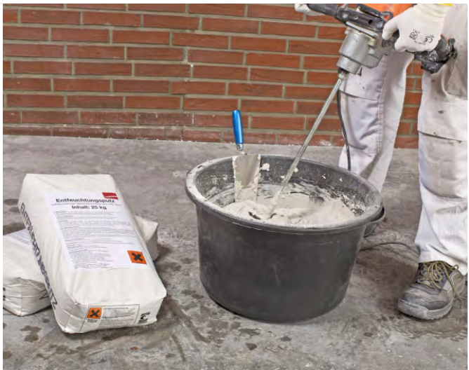
Abb. 7.22: Sanierputz anmischen
