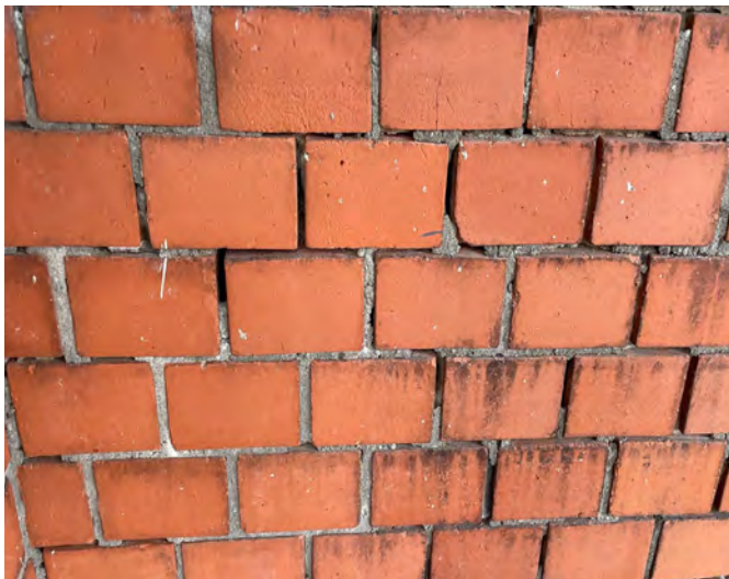
Abb. 5.4: Fugenschäden
