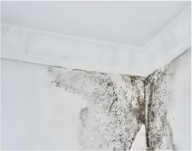
Abb. 13.3: Beispielbild Feuchteschäden
