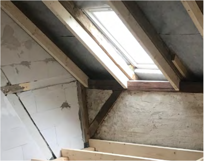
Abb. 16.8: Aufdopplung Sparren und Auflager Fußpfette
