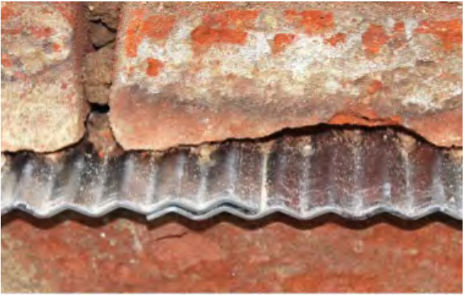
Abb. 4.10: Überlappung der Edelstahlbleche
