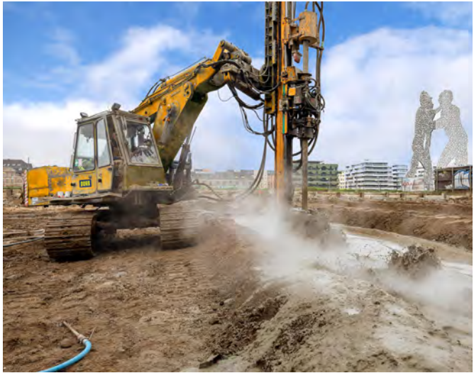
Abb. 2.15: Bohrergerät für Düsenstrahlverfahren
