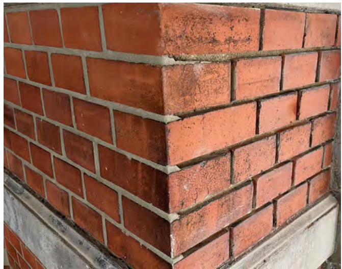
Abb. 5.13: Vormauerwerk Neuverfügt (links) und teilentnommene Fugen (rechts)
