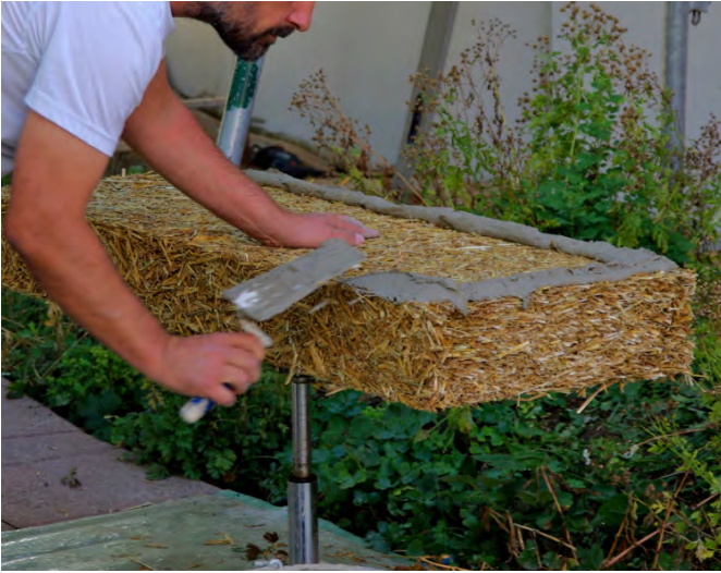
Abb. 14.17: Befestigung Strohdämmplatte
