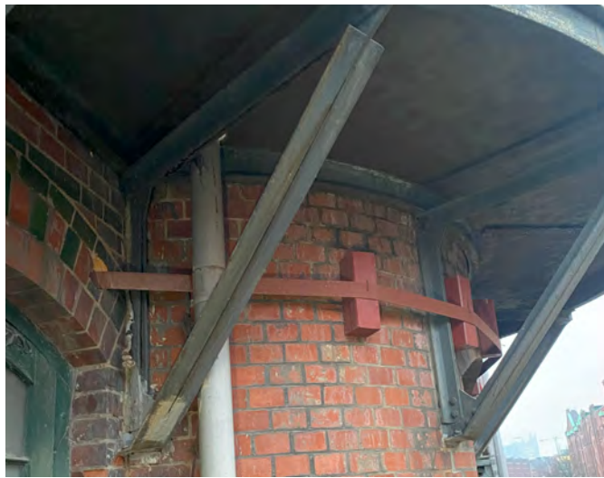
Abb. 6.25: Zugband zur temporären Absicherung
