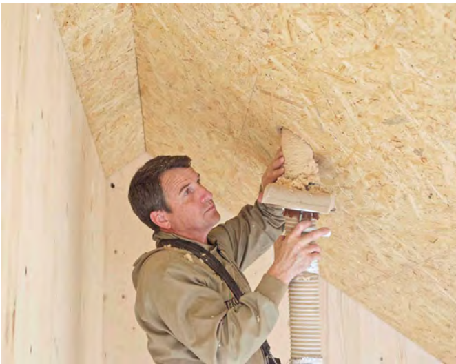
Abb. 17.16: Einbringen der Holzfaser-Einblasdämmung
