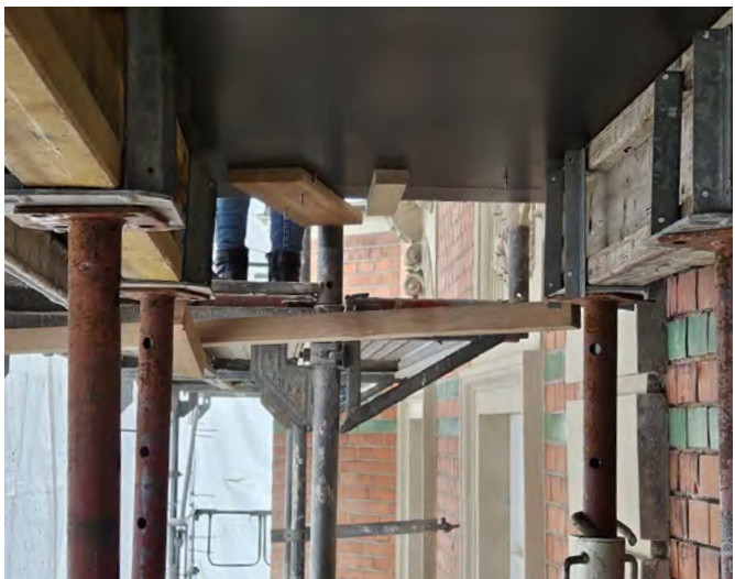
Abb. 9.11: Schalung, abgestützt durch Teleskopstützen
