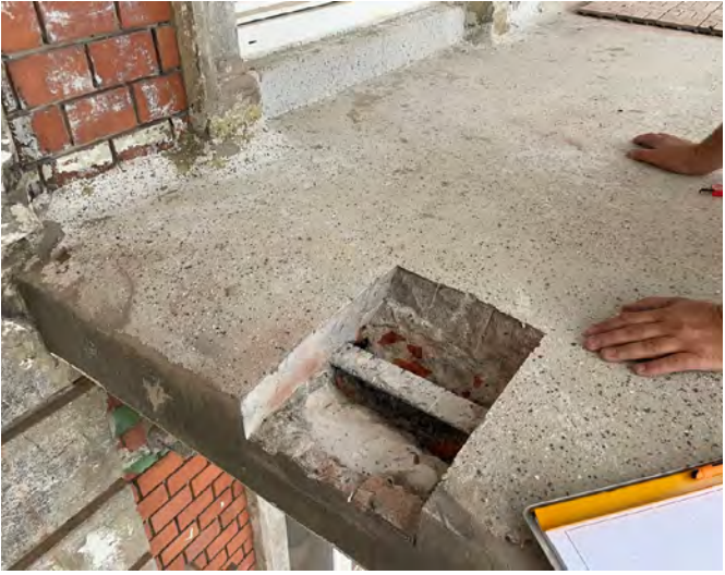
Abb. 9.2: IPN-Träger, Abstand Längsseite
