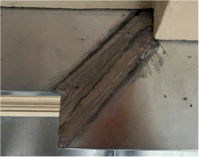
Abb. 8.11 Aufwändige Blecharbeiten mit vorgekanteten Stücken
