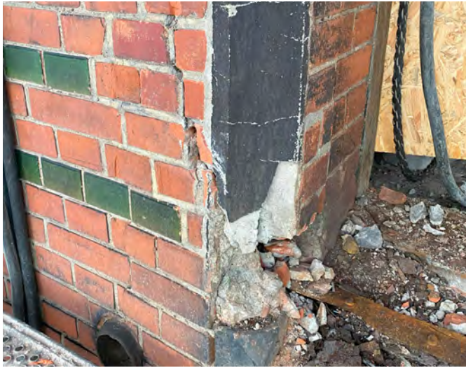
Abb. 6.22: Korrosionsschäden
