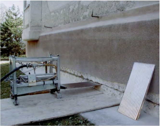
Abb. 4.9: Rüttelgerät beim Schlitzrüttelverfahren
