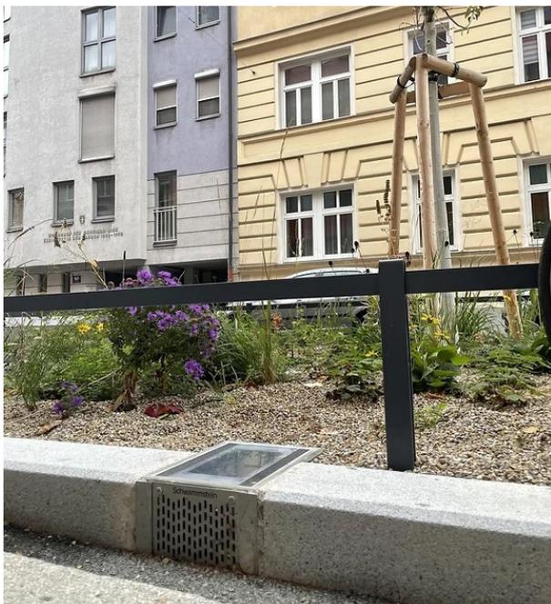
Abb.: 104 Beispiel eines aktiven automatisierten Systems zur Trennung von Sommer- und Winterbetrieb über automatischen Verschluss des Zulaufs über einen Temperatursensor (Foto: [www.schwammstein.at](http://www.schwammstein.at)).
