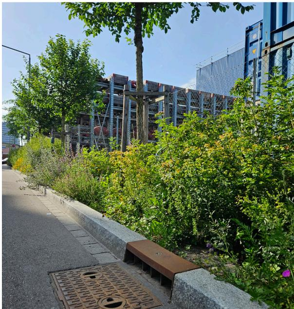
Abb.: 59 Schwammstadt-Baustein Giessereistraße Zürich (links: Michael Richter, HCU), Versuchsaufbau zur Untersuchung der Wurzelentwicklung auf dem ZHAW Campus (rechts: Kirya Heinemann, HCU)
