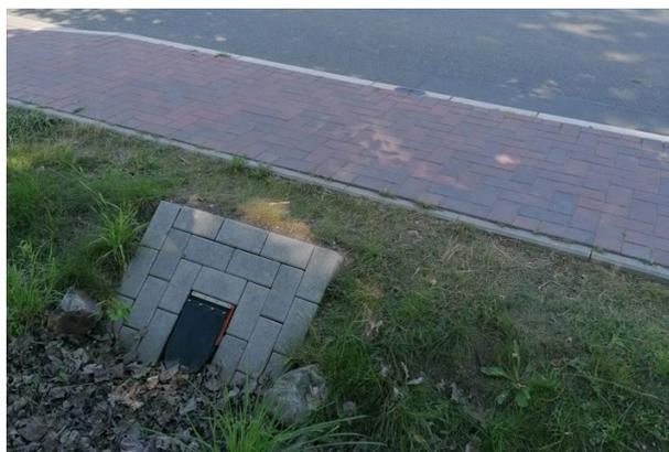
Abb.: 15 Einsatz von Hohlborddrinnen zur Wasserquerung unterhalb von Gehwegen (Quelle: ACO)
